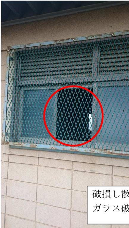
外金網にもかかわらず外側からの衝撃でガラスが破損
