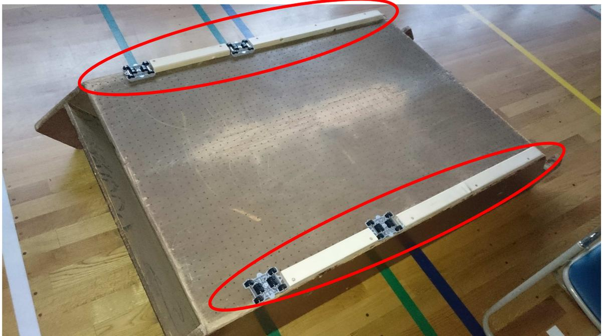
階段裏側にキャスタ及び添え板を配置して階段本体の底面が壇上床面と接しないように工夫した。
