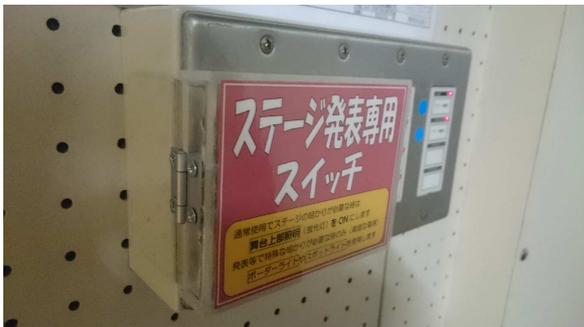
アクリル樹脂にてカバーを製作して現状のスイッチ本体部に貼り付け取付
