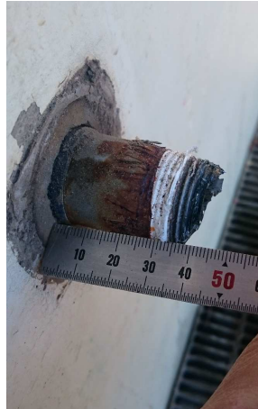
↑蛇口を取り外した状態の配管サイズ (3/4B 6分)
