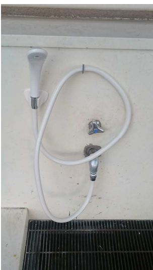
エルボを使って配管サイズをシャワー取付サイズに変換する (3/4B→1/2B 4分)
