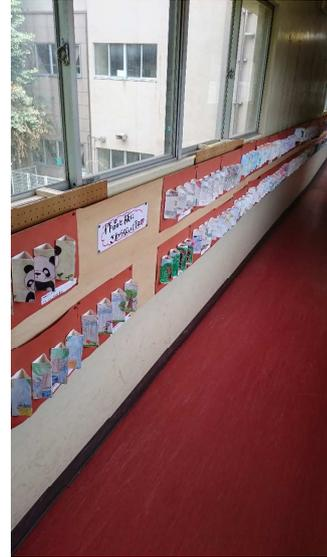
製作で心掛けたのは、現状の通路ではボードを固定できる物がコンクリート壁なのでないということから窓の引き戸溝を利用して取り付ける工夫を行った。
