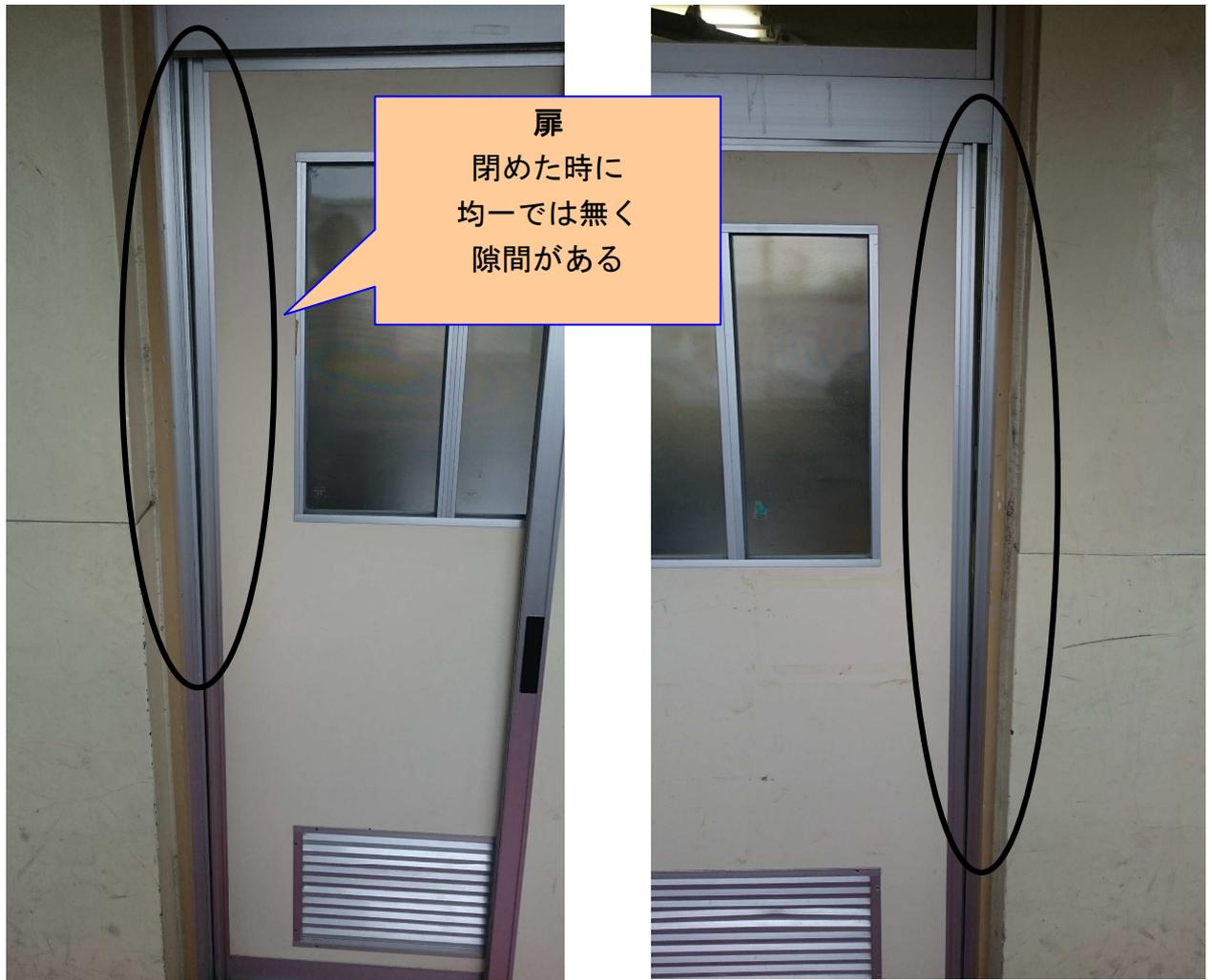
閉じたときに垂直方向で、隙間があるとキーロックが出来ないとか開閉時に異音が出て重い開閉になる場合が殆どである。
